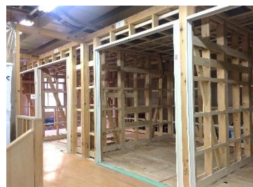
住宅設備工事を学ぶ建物。実際に電気・配管工事などを施す。
