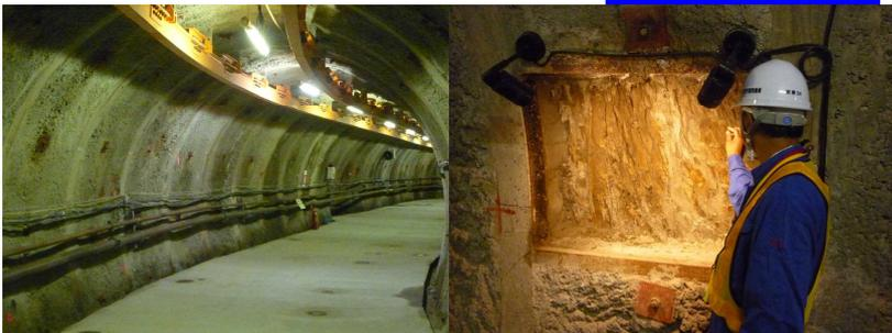
6月に完成した深度350mの調査坑道。約400万年前に堆積した地層。直接接触
